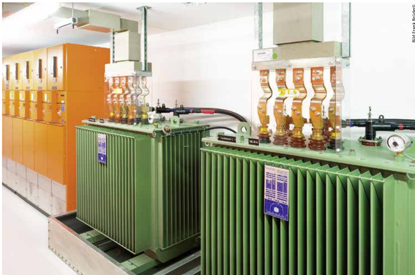
Neue Transformatoren im Bau Y11 auf dem Campus Irchel versorgen dank ihres hohen Wirkungsgrads das Datacenter effizient mit elektrischer Energie.
